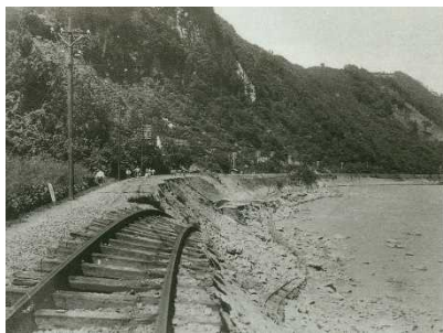
図 2. 2 カスリーン台風による災害状況（国道 17 号、上越線の崩壊） 図 2. 3 カスリーン台風による水害被害図
