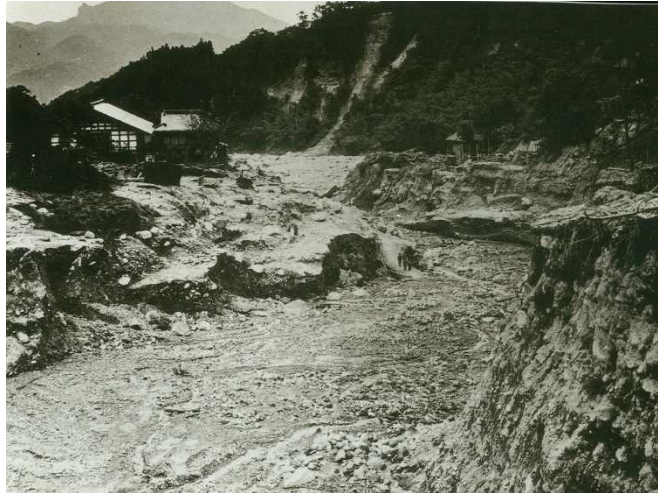
図 2. 1 カスリーン台風による災害状況（山津波（土石流）による災害、赤城村）
